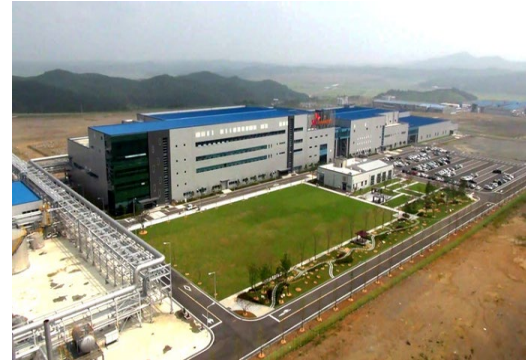
SK온 배터리 서산3공장
